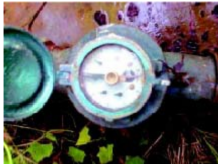
Fig. 8.5 Water meter
